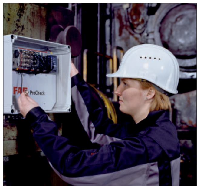
Getriebeüberwachung an der Warmwalzstraße
